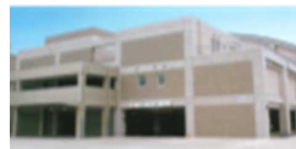
【障害者スポーツ交流館】
