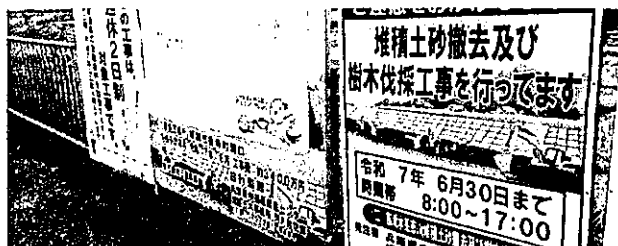
「市川水系市川堆積土砂撤去及び樹木伐採工事（施工場所：香寺町溝口）」
