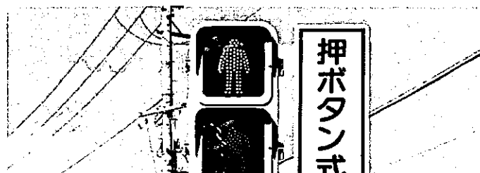
信号機設置完了
