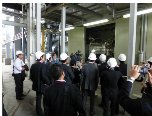
（ガスタービン設備の説明）
