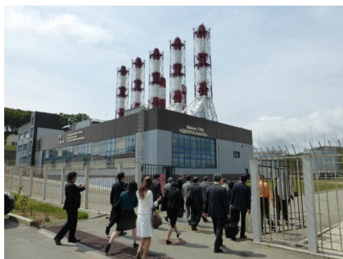
（熱併給発電所の視察）
