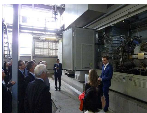
(ガスタービン設備の説明)
