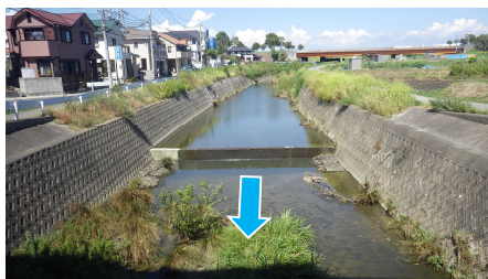
河川の状況（第二柳井橋付近）
