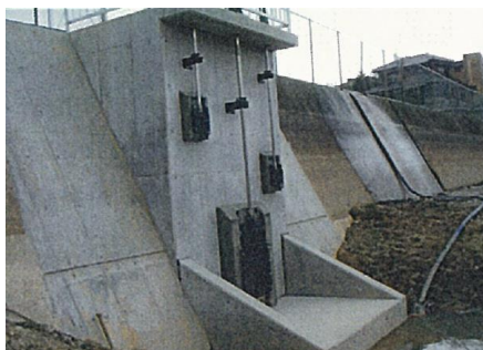
明石市の西脇皿池での緊急放流設備の整備
