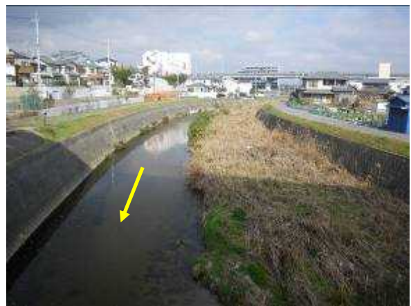
图 28 谷八木川下流部
