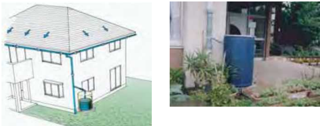
図 53 各戸貯留施設の例(地上タイプ)
