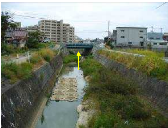
图 27 谷八木川中流部
