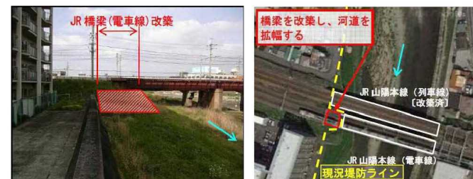
<明石市西新町 さいしんまち 地内(JR橋梁改築部)> <明石市西新町 さいしんまち 地内~茶園場町 さだんばちのち 地内>
