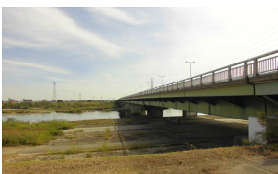
橋梁耐震化（播州大橋）
