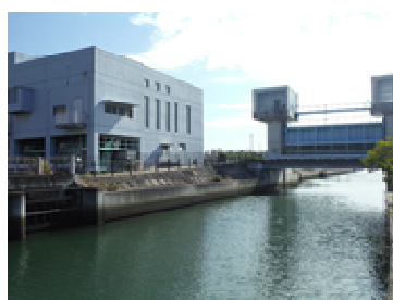
水門機械設備の更新（加古川）
