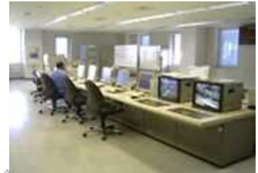
施設更新（加古川下流浄化センター監視設備）
