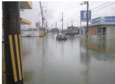
：小原宝殿停車場線の出水状況
