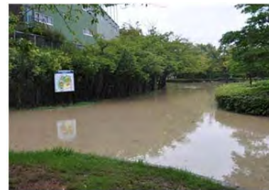
写真：高砂市総合運動公園の出水状況
