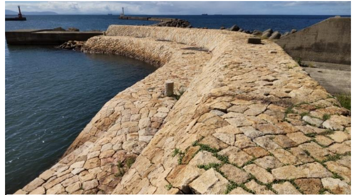
西防波堤 L=25m
