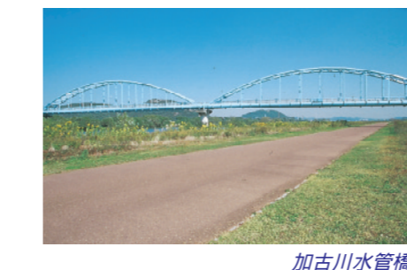
加古川水管橋
