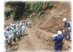
作業道作設 実習
