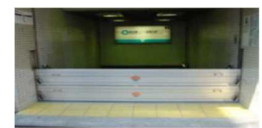
地下鉄出入口の浸水対策
