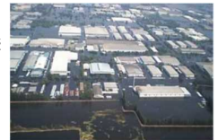
タイの工業団地の浸水状況 (2011年10月)
