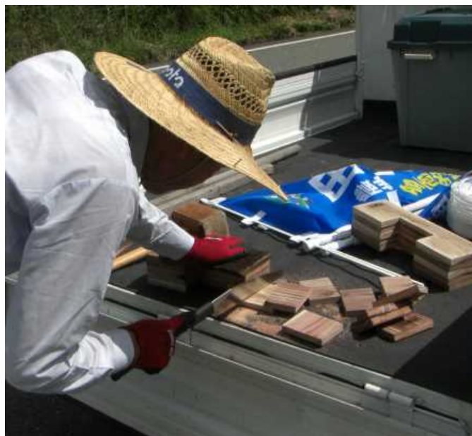
手作り 田んぼダム (幅の調整作業)
