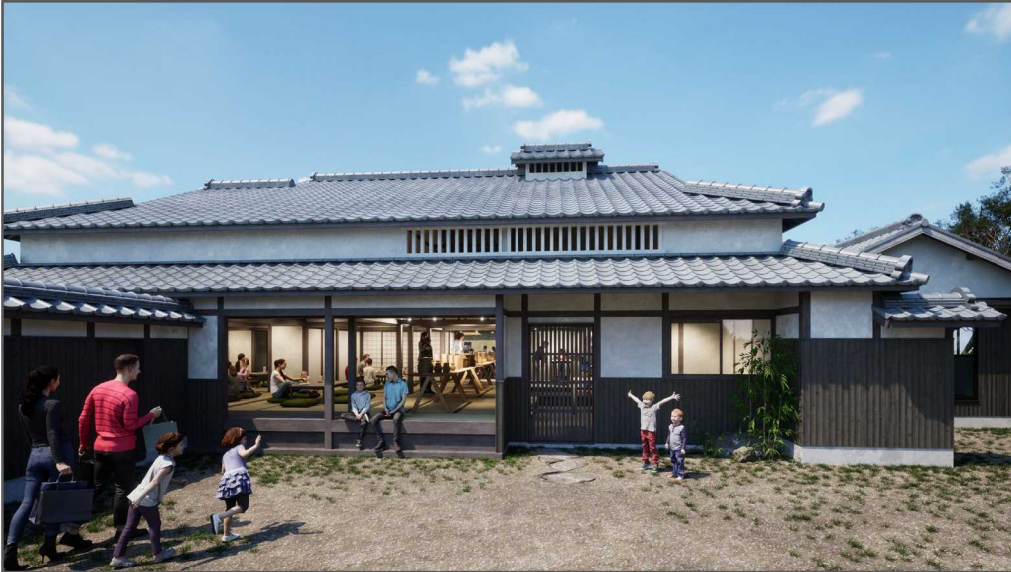
<外観 建物正面>
