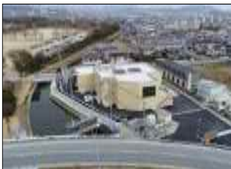
間の川ポンプ場(高砂市) 平成30年3月完成
