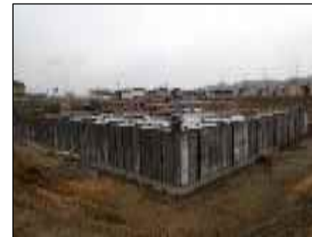
糸引公園雨水貯留施設(姫路市) 令和元年7月完成
