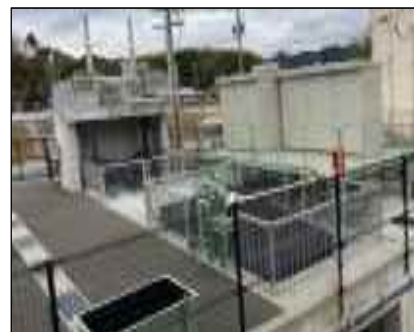
京口排水ポンプ場(丹波篠山市) 平成30年6月完成
