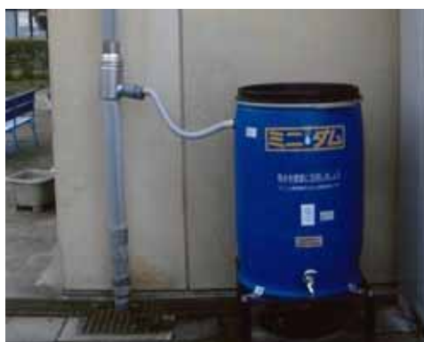
大雨の前に放流することが雨水の流出抑制を図る上で有効です。
