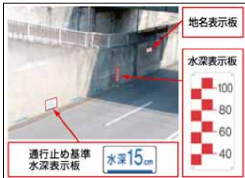
冠水対策用表示板の設置 （水深表示板・地名表示板）
