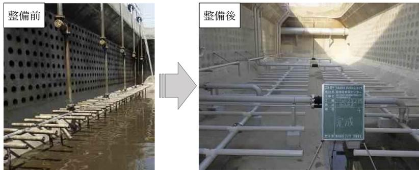
老朽化した散気装置を更新
