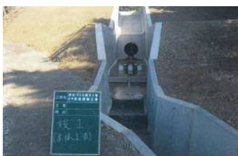
洪水吐・放流管 (堤体正面)
