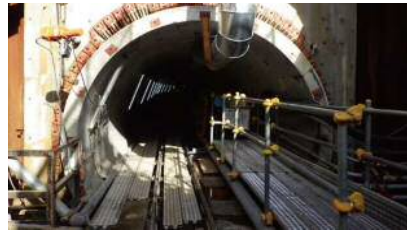
導水路坑口状況
