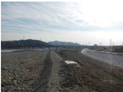
二級河川 市川《JR橋梁工区》 護岸・掘削<平成29年度完成予定>
