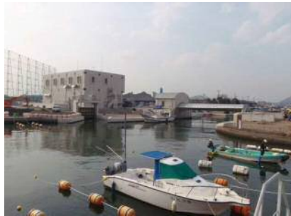
二級河川 八家川《排水機場整備》 水門・排水機場<平成29年度完了予定>
