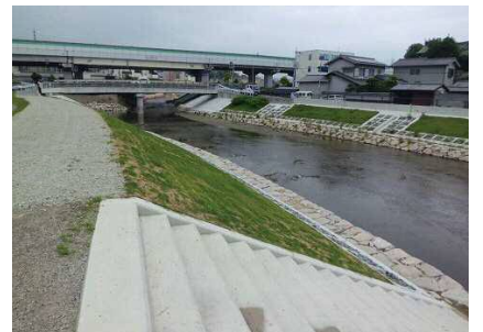
二級河川 船場川《飯田工区》 護岸・掘削・橋梁<平成29年度完成予定>
