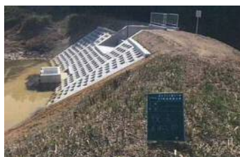
洪水吐・オリフィス樹 (堤体樹裏法面)
