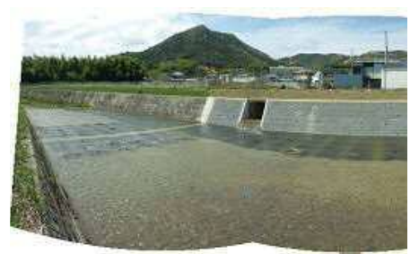
二級河川 天川《姫路市飾東町豊国》 平成26年 河川災害復旧事業
