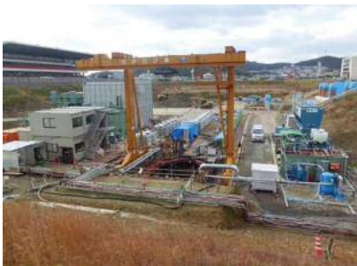
二級河川 船場川《洪水調節池》 調節池掘削・導水路
