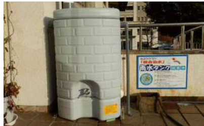
兵庫県 姫路庁舎雨水貯留タンク N=1基(200ℓ)(姫路市北条1-98)
