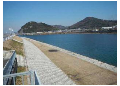
二級河川 市川《阿成工区》 護岸・掘削<平成28年度完成>
