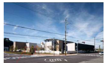
太子町 屋外倉庫雨水貯留槽 V=77 m 3 (太子町庁舎)
