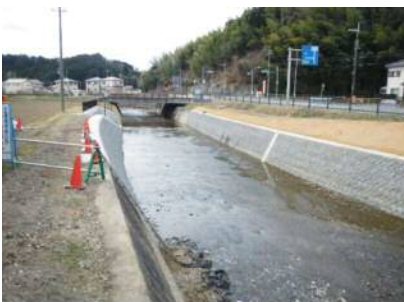
二級河川 恒屋川《香寺町中寺》 護岸・掘削他<平成28年度完成>
