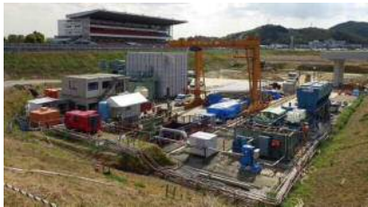
導水路工事仮設備状況
