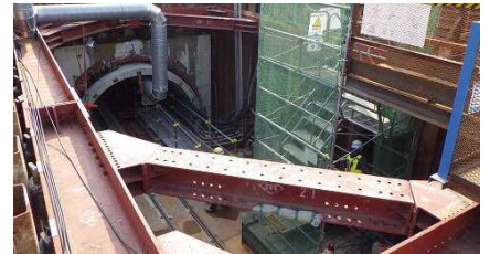
発進立坑状況
