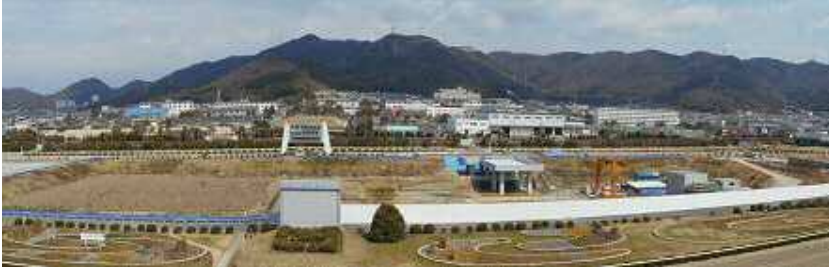
洪水調節池全景
