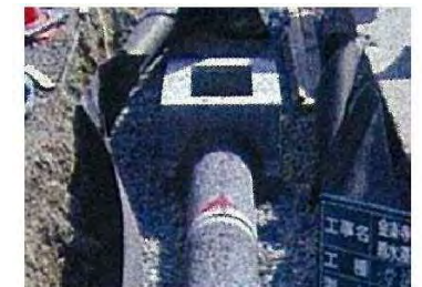
その他の雨水貯留浸透の取組（左：雨水貯留タンク、右：浸透管・浸透枳）
