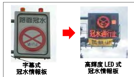
冠水情報板の高輝度 LED 式化
