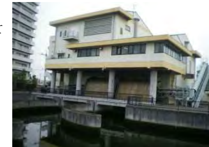
野田川排水機場
