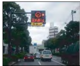
冠水情報板の設置
