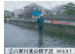
②八家川東山橋下流 H16.9.7
