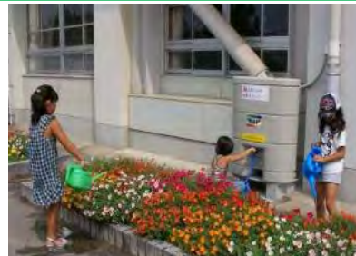
姫路市の小学校に設置されている雨水貯留タンク
