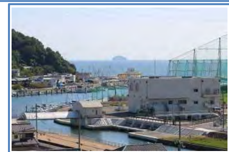
八家川排水機場
