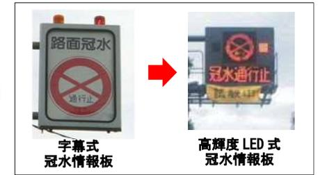
冠水情報板の高輝度LED式化
