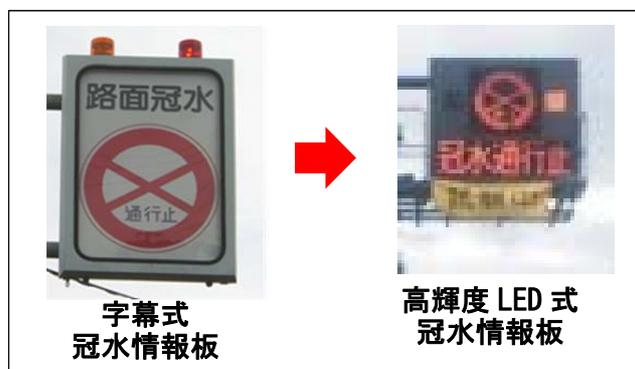
冠水情報板の高輝度LED式化
