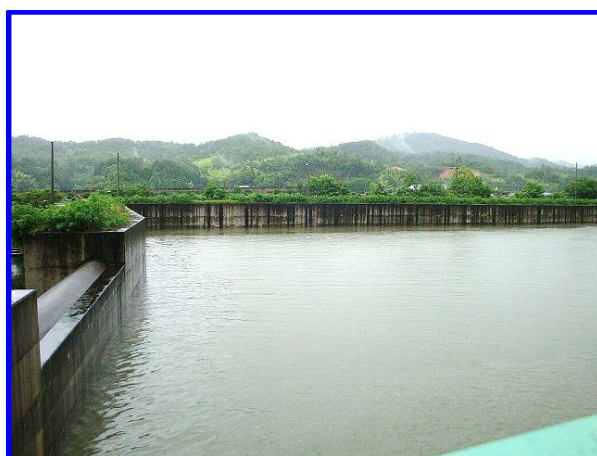
福崎町－福崎工業団地調整池
