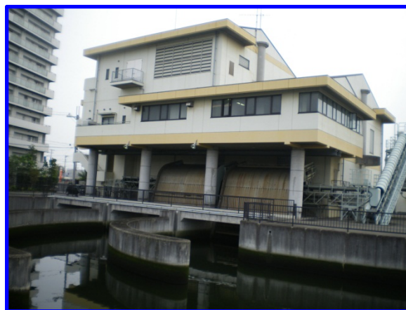
野田川排水機場
