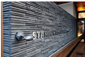
スターバックス淡路SA店の壁材
