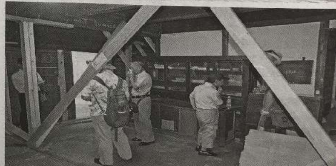
補強が施された米田邸の土間。物が傾斜しているところ
