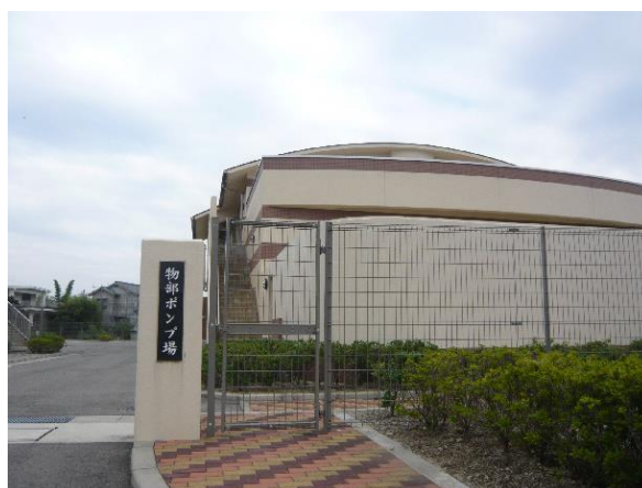
物部ポンプ場（洲本市）
