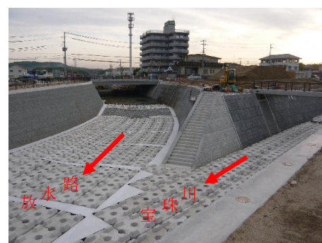
志筑川放水路と 宝珠川の合流部
