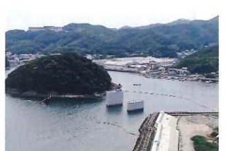
令和3年12月 煙島水門の設置
