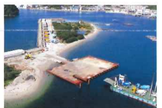
平成30年10月 洲崎工区 仮設栈橋の完成
