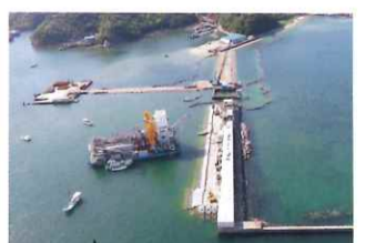
令和2年6月 新設、かさ上げを進める
