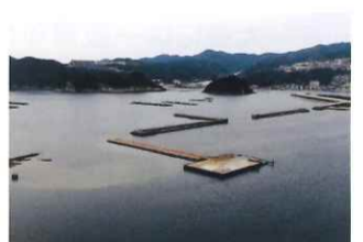
平成31年2月 じゃのひれ側 仮設栈橋
