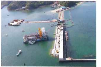
令和2年6月 新設、かさ上げを進める
