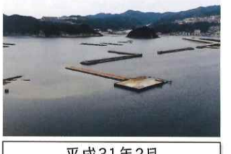
平成31年2月 じゃのひれ側 仮設栈橋
