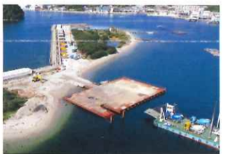
平成30年10月 洲崎工区 仮設栈橋の完成
