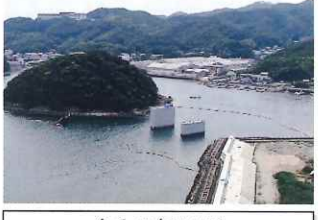
令和3年12月 煙島水門の設置
