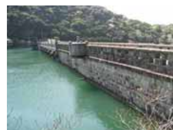
山側から見た石積み式堤体
