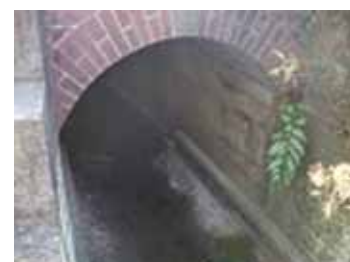
水路トンネル
