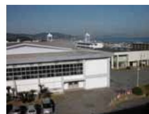
東浦中学校校舎と大阪湾 （明石海峡大橋方面に望む）
