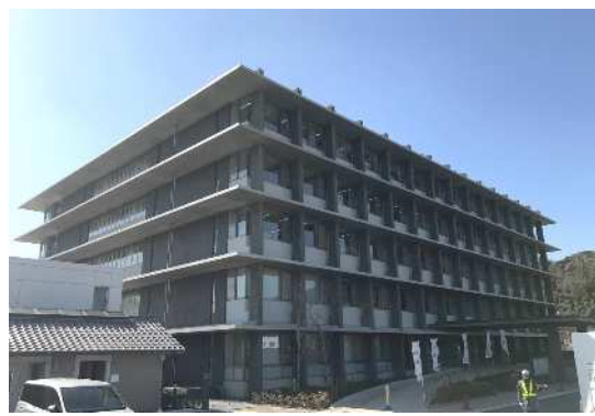
図 48 洲本総合庁舎の建物嵩上げ
