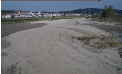
洲本川(上内膳から桑間)※破堤
