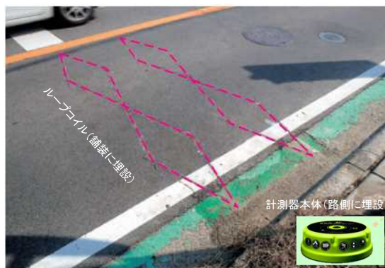
観測機器の設置状況
