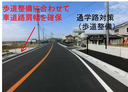
道路事業に合わせた路肩整備
