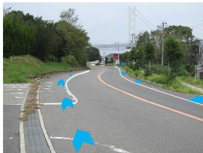
路面表示(矢羽根)設置
