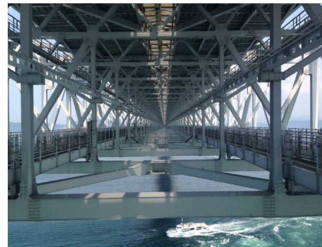
大鳴門橋桁下空間(現況)
