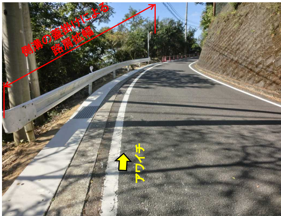
県道洲本灘賀集線(洲本市由良町由良)
