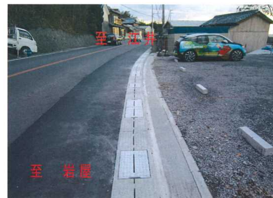
側溝の蓋がけによる路肩幅確保(淡路市)
