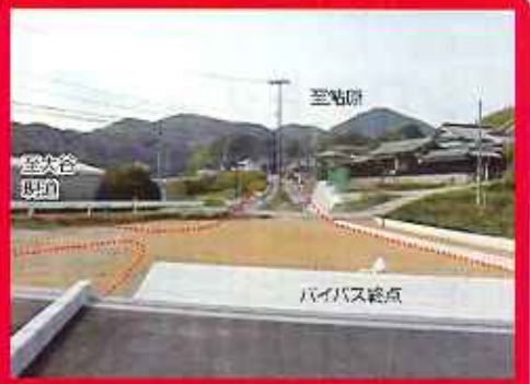
大谷鮎原神代線道路改良工事 （木曾下バイパス） 道幅が狭く、歩道がないため交通が混雑している道路をバイパスにする工事です。2車線歩道（片側）にすることで、安全かつスムーズに通ることが出来ます。来春3月に開通する予定です。
