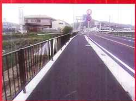
志知交差点改良・歩道整備工事 渋滞交差点を解消するため右折レーンを設置します。また、歩行者の安全を確保するために、歩道を整備します。
