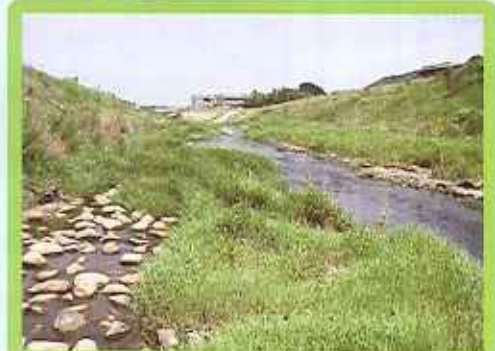
洲本川改修工事（洲本市下加茂） 洲本川改修工事では安全な川づくりとあわせて、植物の生えやすい材料を使うなど、川のまわりの環境に配慮した川づくりを進めています。工事が終わったところでは、たくさんの植物が育っています。
