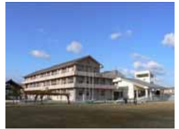
松帆小学校校舎
