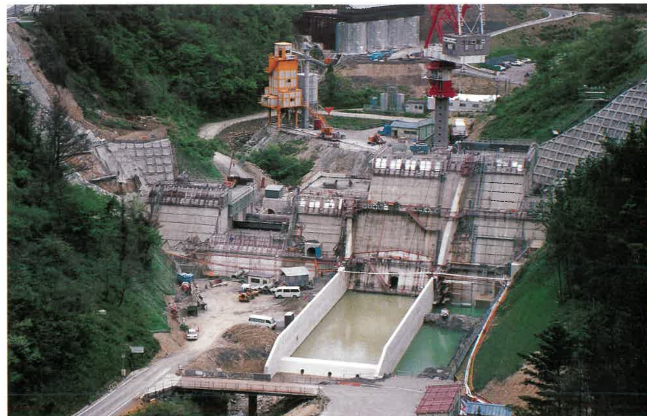
平成4年4月（コンクリート打設状況）
