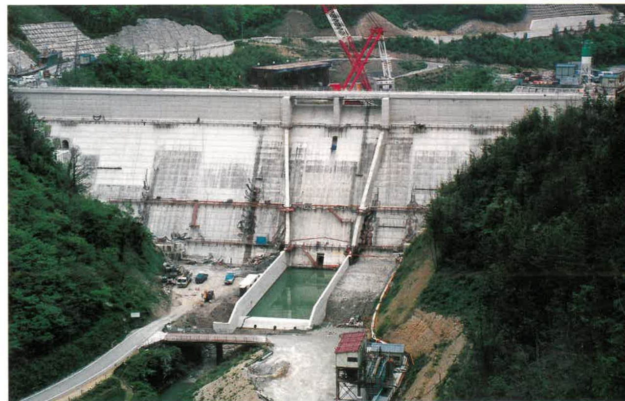
平成5年4月（コンクリート打設終了）
