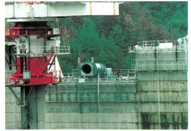
常用洪水吐放流管（上流より）
