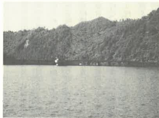
大日川ダム全景
